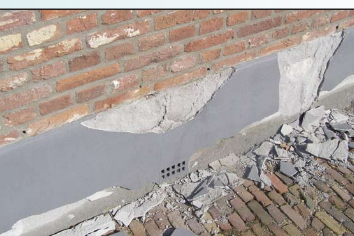
Een detail van een stukadoorswerk onder en ter plaatse van het maaiveld met een laag DPC-folie.
